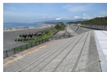
海拔17mの防潮堤
