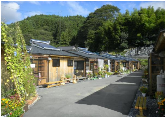
解体（整備）前の仮設住宅本町団地
